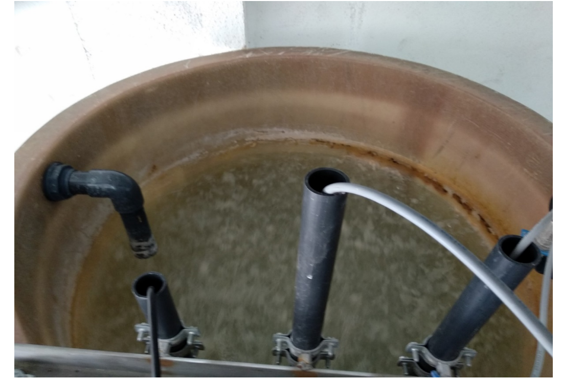
SONDAS DE CONTROL QUÍMICO
