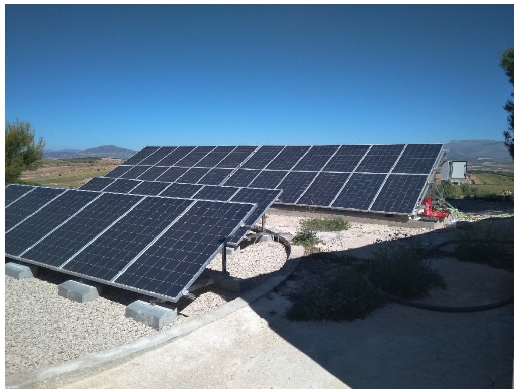
PLACAS SOLARES FOTOVOLTAICAS
