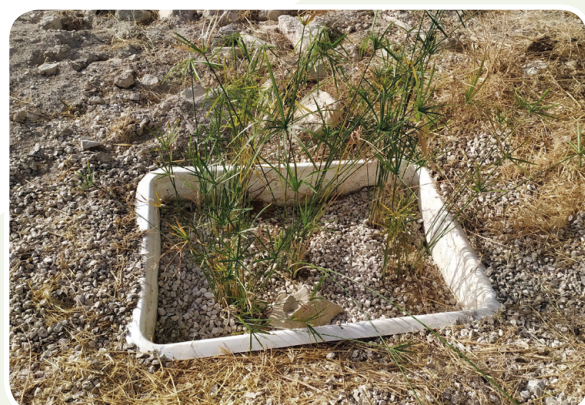
Humedal artificial para el tratamiento del agua de lavado del filtro de arena.
